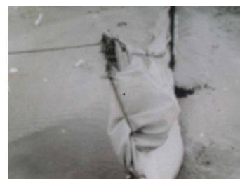
FIG. 7. Estacadas con sacos para retener la arena, cimiente de las dunas actuales.
