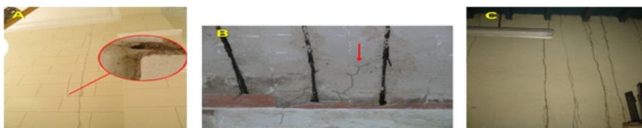
FIGURA 4. Evidencias de infestación de Heterotermes sp. A y C: túneles construidos en paredes, B: túneles en techos.
