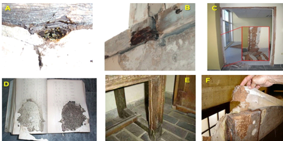
FIGURA 3. Daños causados por Coptotermes gestroi . A y B: en dinteles, C: en marcos de puertas, D: en papel, E: en muebles, F: en textil.
