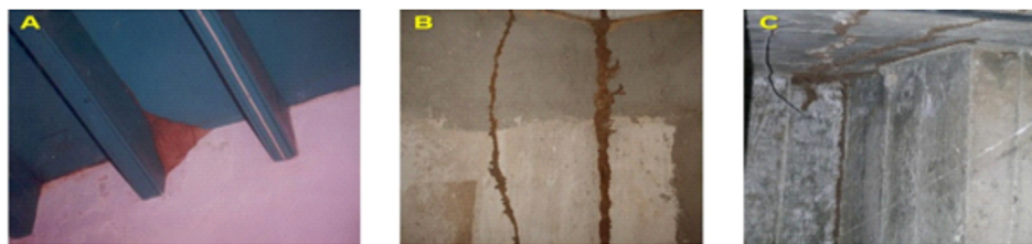
FIGURA 2. Evidencias de infestación de Coptotermes gestroi . A: formación de nidos secundarios o aéreos en techos, B y C: túneles construidos en paredes y techos.
